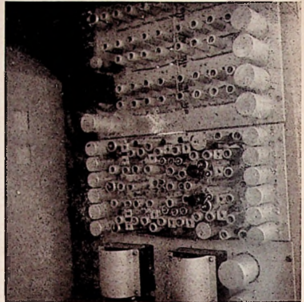
Golfgenerator (boven). Cameraversterkers (midden) Voeding (onder).
